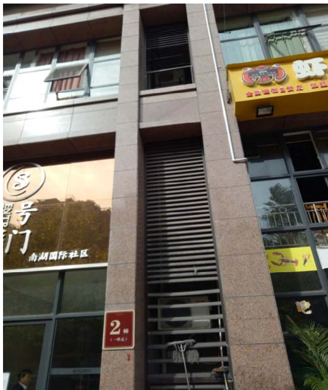
附图 10：空调机位与冷凝下水管
